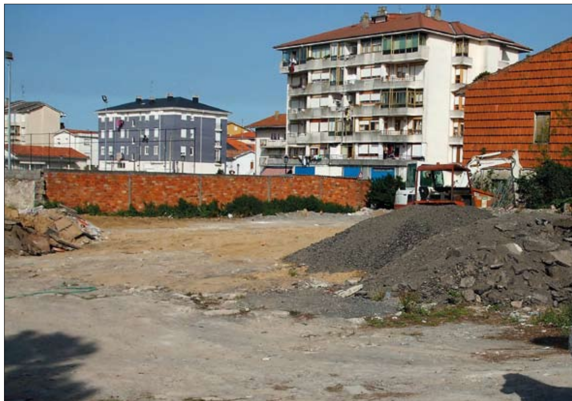
Zona donde se acumulan los escombros en la parcela municipal de 'La Salinera'. / BEDIA
