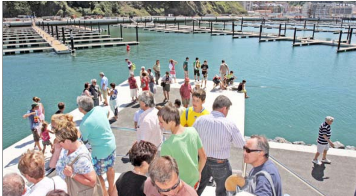
Visitantes en el muro sur del nuevo puerto deportivo de Laredo. / BEDIA
