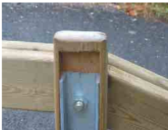
Detalle de barrera de seguridad mixta metal-madera
